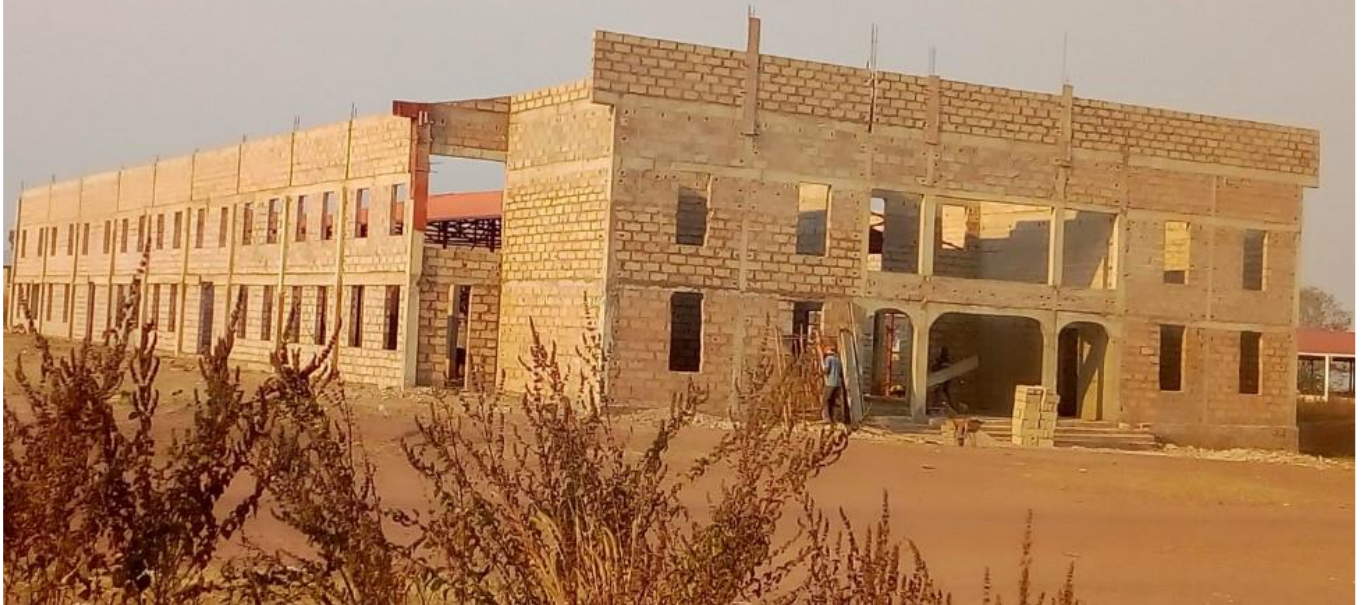
Templo do Dundo em construção
